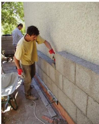
Figure 16 : Mise en œuvre de bloc de chanvre pour une ITE
